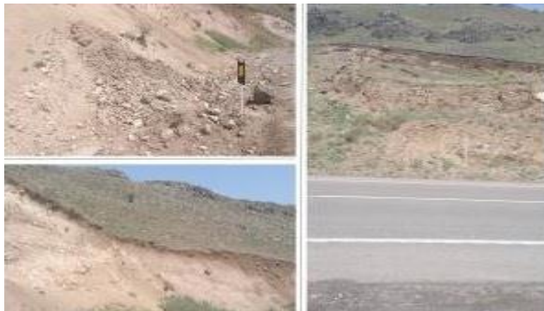
شکل ۶. قش شیب و بریدگی‌های عمودی در زمین لغزش منطقه و کناره‌های جاده (مأخذ: نگارندگان)
