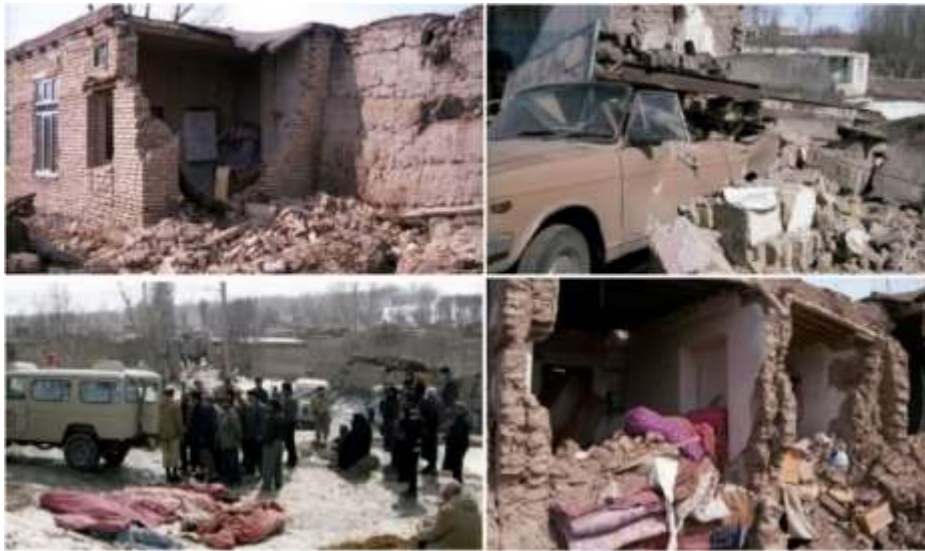
شکل (۱). تصاویری از خسارات جانی و مالی ناشی از زلزله رخ داده در مورخه ۱۳۷۵/۱۲/۱۰ اردبیل
