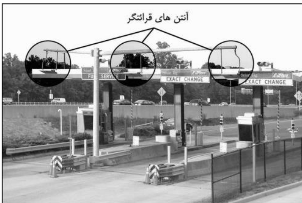
شکل (۱). چگونگی شناسایی خودرو برای اخذ عوارض بصورت الکترونیکی و خودکار
