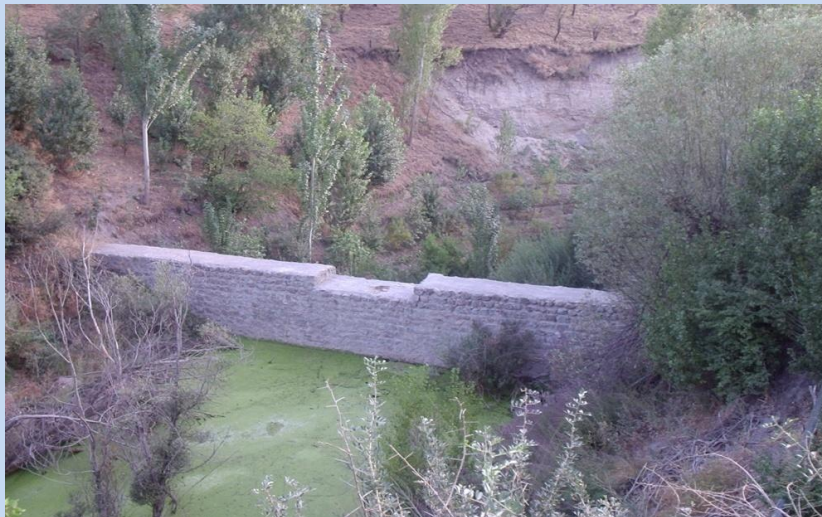
شکل شماره 9) اجرای عملیات سازه‌های در آبراهه‌های اطراف روستای ازبک
