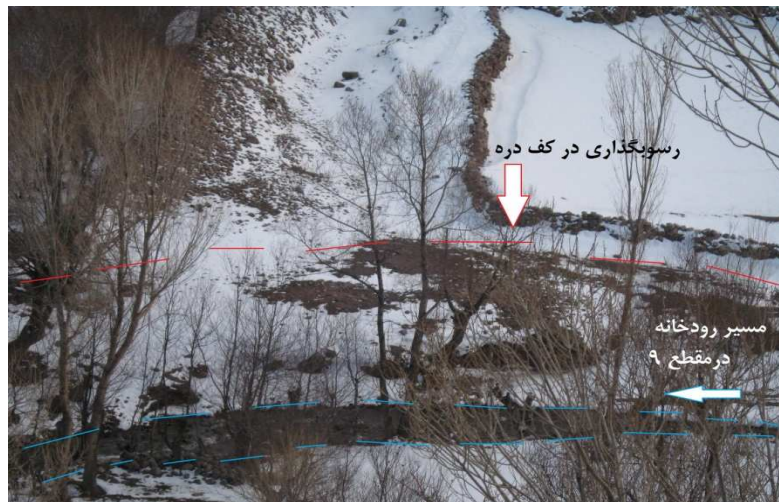
شکل (۱۲) مقطع شماره ۹ در دره ليقوان
